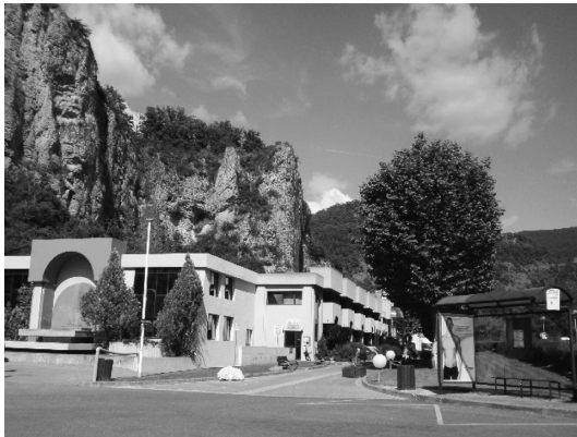
Photo 3 Entrance of Thermes, Digne les Bains. (ディーニュ・レ・バンの温泉施設)
