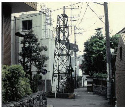
図 17 温泉場・湯元通りの源泉井 (2006 年 著者撮影) 鉄骨やぐらは主に定期的に行う井戸掃除 (源泉井孔内のスケール除去) 用
