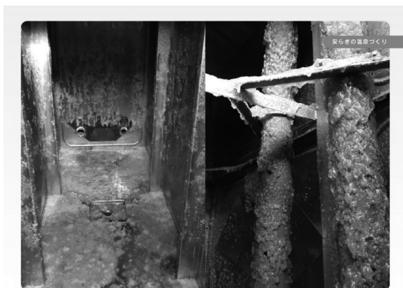
図 2 10 年以上洗浄をしていなかった温泉タンク内のバイオフィーム（参考） ※レジオネラ属菌はバイオフィーム内に生息するアメーバの中で増殖する。
